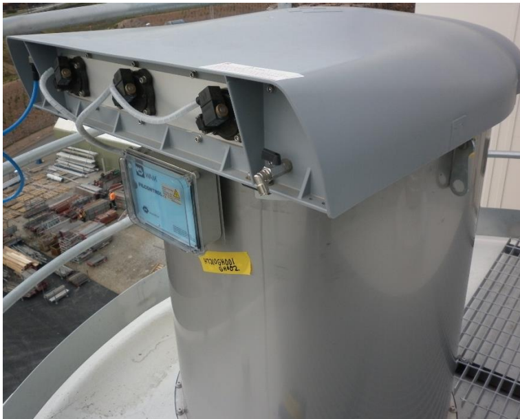
Silotopfilter 24 m 2 med pulsrensingsautomatik
