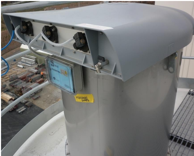
Silotopfilter 24 m 2 med pulsrensingsautomatik
